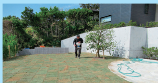
個人宅芝生施工
